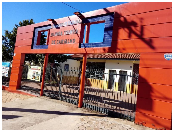
Figura 1: Entrada do colégio
